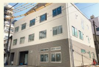
たぐいまる新社屋建設中!!
